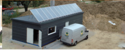
Energiekabine mit Solarkollektor
