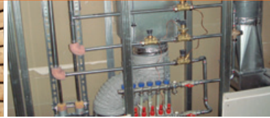
Anschluss Fußbodenheizung
