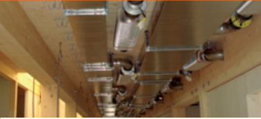
Lüftungskanäle
